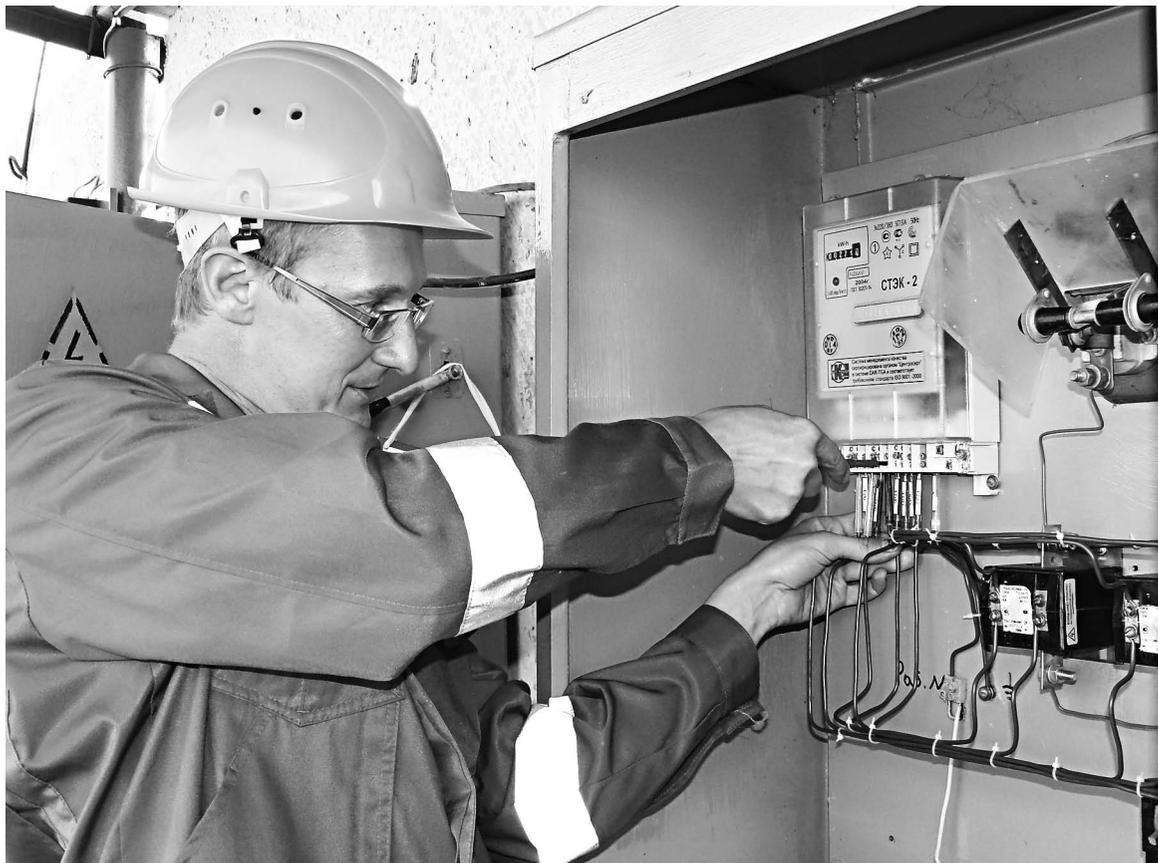
С помощью нового оборудования обеспечиваются оперативность и автоматизация сбора информации о потреблённой электроэнергии и мощности.
