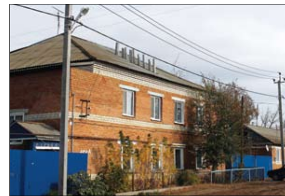
Саратовская область, г. Красноармейск, п. Текстильщики: построены новые внутриквартальные сети 0,4 кВ, электроснабжение переведено на новую трансформаторную подстанцию 250 кВ, установлено новое осветительное оборудование.
