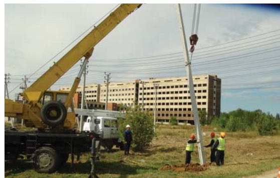
Установлена опора №1 будущей электросети.
